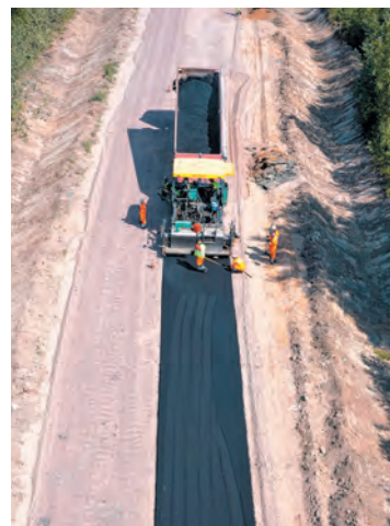
В планах на 2024 год — ремонт 200 км автодорог
