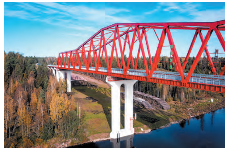
В Ленобласти продолжается строительство и ремонт мостов
